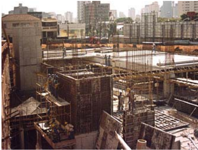
A Matec construiu o prédio de 10 mil m 2 úteis em 14 meses. O edifício tem layout flexível e plano de expansão
