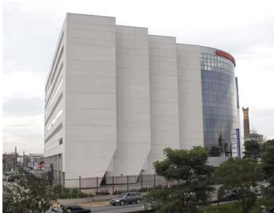
A fachada escalonada com o volume curvo surgiu em menos de seis meses em um trecho da Marginal do Tietê na zona Norte de São Paulo. O projeto teve de se adaptar ao prazo exíguo, ao programa extenso e até a uma paineira existente no terreno
